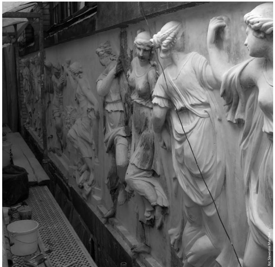
W trakcie renowacji
